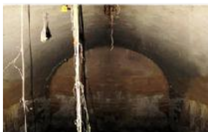
Interior del aljibe de la casa colonial del ingenio, con más de 280 años
