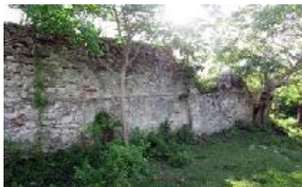
Paredes del ingenio aún en pie con más de 280 años desde su construcción.
