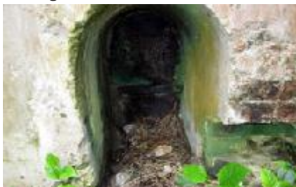
Compuerta de la represa, aún con su estructura interior de hierro
